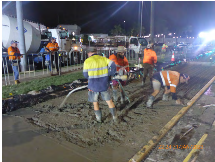
First bus laydown concrete pour
